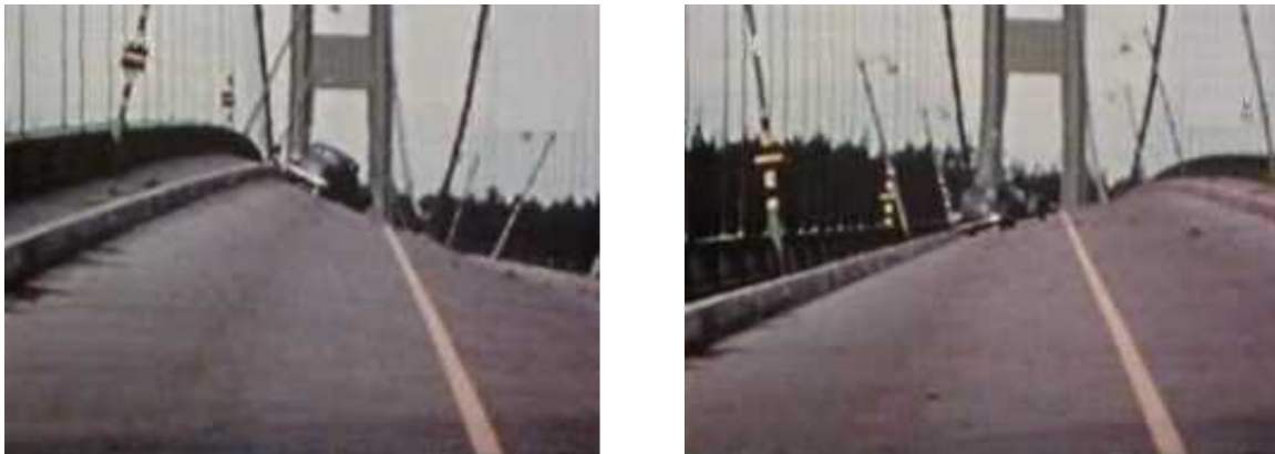
(c) Die Tacoma Narrows Brücke kurz vor dem Einsturz am 7. Nov. 1940: Einige Wochen nach der Fertigstellung begann die Brücke bei ungünstigen Windverhältnissen zu Schwingen.
